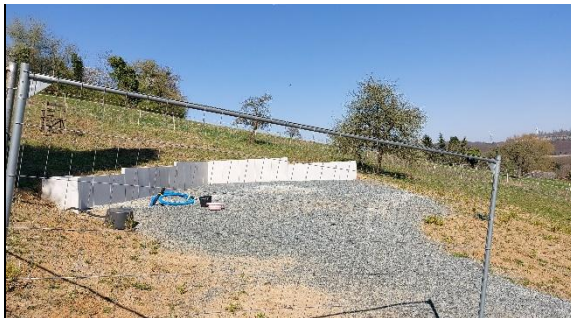
Abbildung 10: Baustelle KiTa westlich von Teilbereich 1
